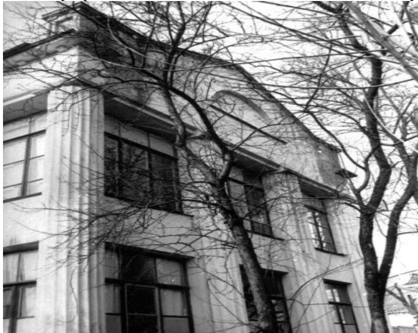
Главный фасад здания
