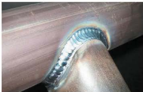
Рис. 2.10. Соединение труб электродуговой сваркой
