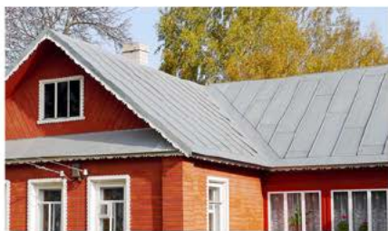
Рис. 5.3. Крыша из оцинкованного листа
