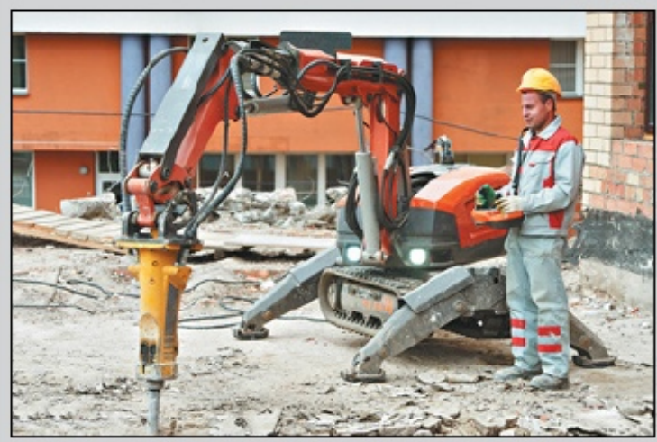
Рис. 20. Гидроманипулятор, управляемый оператором дистанционно
