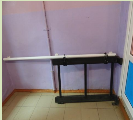
Пандус в здании школы
