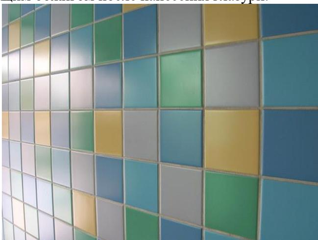
Плитка имеет различные размеры при толщине 12 мм, а покрытая светлой глазурью поверхность напоминает внешне мрамор.
