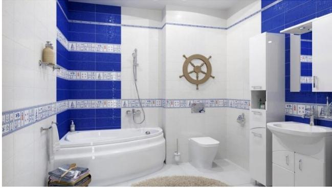
Помимо традиционных бордюров, при внутренней отделке помещений используют и бордюры-карандаши, выполненные в виде барельефа. Их укладывают в местах стыка настенной и напольной или настенной и потолочной плитки.
