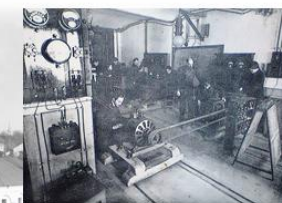
1897 год - Первая электростанция в Костроме заработала в здании Химико-технического училища имени Ф.В.Чижова
