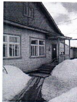
фото.№8 входная площадка (перед дверью) группа №6
