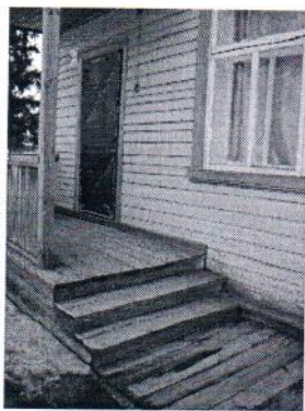
Фото №7 входная площадка (перед дверью) группа №4
