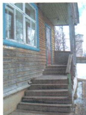
фото №6 входная площадка (перед дверью) группа №2
