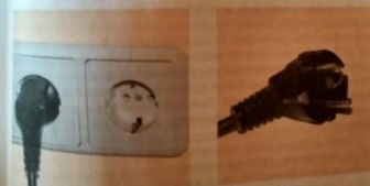
Рис. 173. Блок розеток и вилка с дополнительными заземляющими контактами
