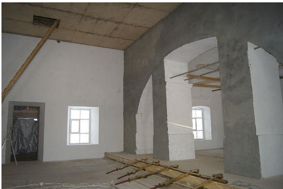
(вид внутри храма, после ремонта, фото 2013 год)
