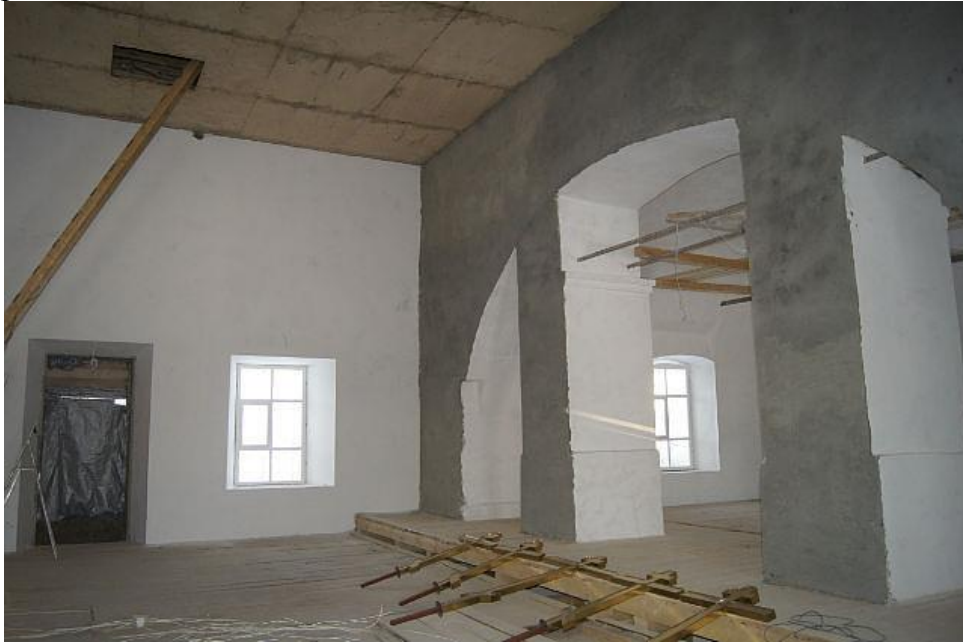
(вид внутри храма, после ремонта, фото 2013 год)
