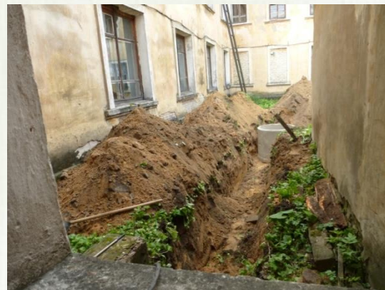
Ремонт канализации
