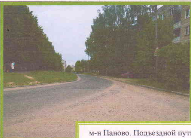
ул. Южная. Пешеходный переход
