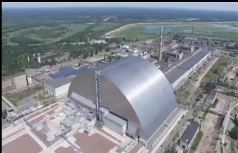
Саркофаг над 4-м энергоблоком
